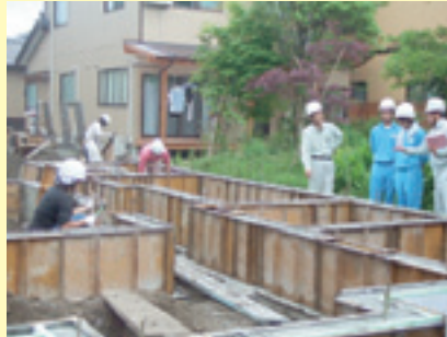
基礎工事現場の見学
