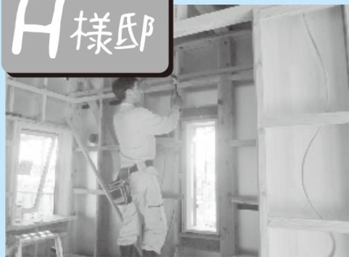
骨組みが完成し断熱材で家を包み込みました。
