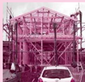
上棟式が終わると・・・外部では、屋根工事・断熱施工・外壁張り、内部では耐震金物付けに取り組み、造作・仕上げと進めていき、夏の完成を目指します。
