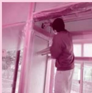
左官職人が和室の壁を、下塗り・中塗り・上塗り（仕上）と何度も丁寧に丁寧に塗っていきます。絶妙なコテさばきで塗り壁を仕上げっていきます。
