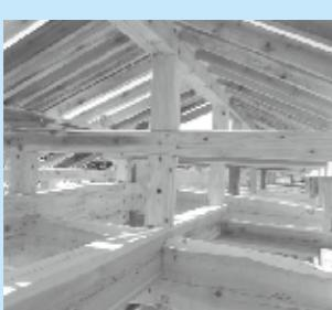
骨太構造が組み上がり、外部では屋根工事・断熱施工・外壁張り、内部では筋交い・耐震金具の取付へと進めていきます。
