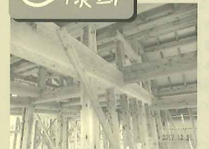
先日、上棟した○様邸です。屋根の下葺きが終わり筋交いや金具の取付をしています。天候を見て窓を取付け断熱材で外部を覆い内部の造作へと進みます。
