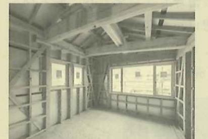
厳選された骨太の木材で強固な構造です。断熱工事で家の天井、床、壁と、家全体が断熱材で覆われました。村上の厳しい寒さ、暑さから住む人を守ってくれます。
