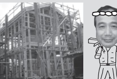
運ばれた材木の柱・梁を看付通りに正確に組み上げました。その後、屋根工事、断熱工事と進めていきます。
